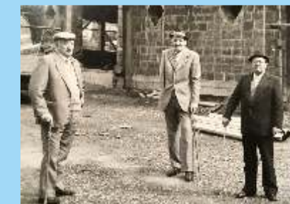
Fotografiert 1988 an der Baustelle des Bürgerhauses Hütschenhausen
